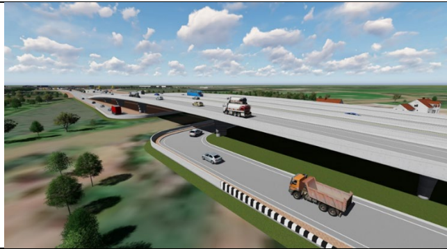
รูปที่ 6-5 รูปแบบจุดกลับรถสำหรับรถขนาดเล็ก (ได้สะพาน)
